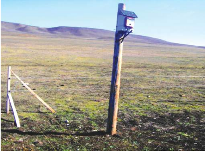
სურათი 31. ელექტროდობის მკვებავი წყარო – მზის 9-ვოლტიანი ფოტოელემენტი 5 კა ფართობის შემოსალობად. სოფელი უდაბნო
