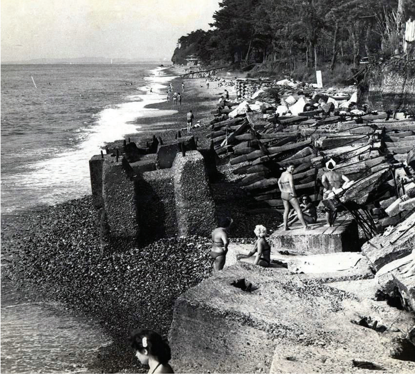
ფოტო 3. მწყობრიდან გამოსული ხისტი საინჟინრო ნაგებობების ნარჩენებისაგან ძლიერ დეგრადირებული ნაპირი სოფ. ბუკნართან (1983)
