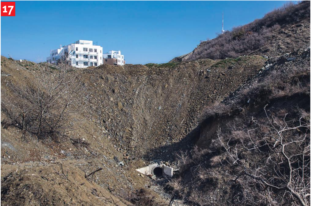
ფოტო 17, 18: კლდოვანი საძირკვლების გათხრის დროს წარმოქმნილი ქვალორღიანი მასალის ჭებირით ვარაზისხევის ძირის გადაკეტვა. ჭებირის ქვეშ არსებული გვირაბის შესასვლელი. წინა პლანზე – ჭებირიდან სულ ასიოდ მეტრის დაშორებით მდებარე მრავალსართულიანი სახლი. ვარაზისხევის ზედა ნაწილის ხეობის ძირი. მარჯვნივ – ჯუს ტბა.
