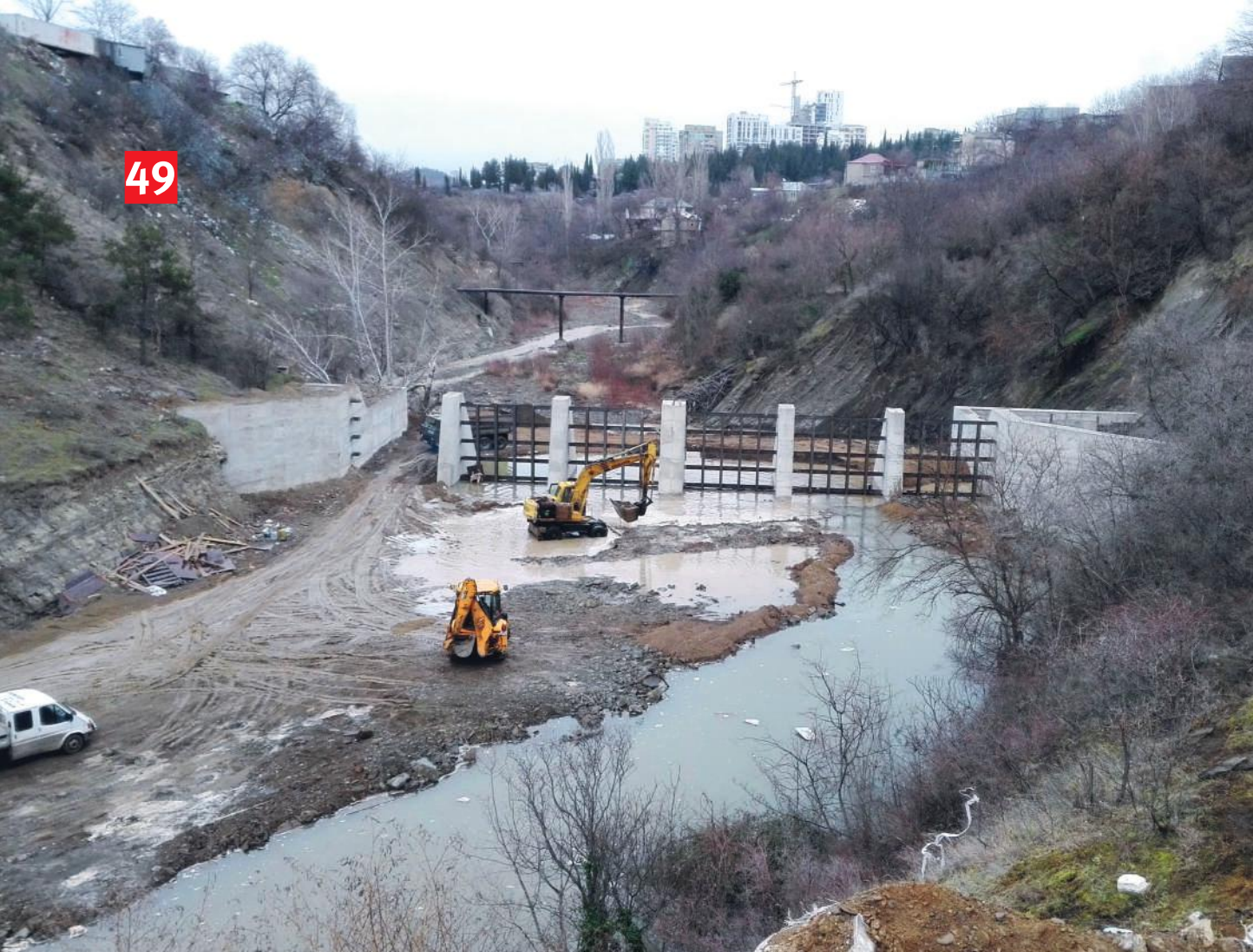
ფოტო 49: მდინარე ვერეზე ქალაქ თბილისის მისადგომებთან აშენებული ცხაურა.
