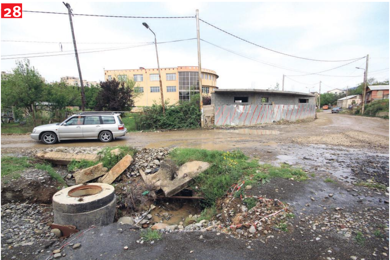
ფოტო 28: სააგარაკო დასახლების ცენტრალურ ნაწილში წყალგამტარი გვირაბი დაზიანებულია და ფეკალური წყლებით იტბორება ქუჩის სავალი ნაწილი.
