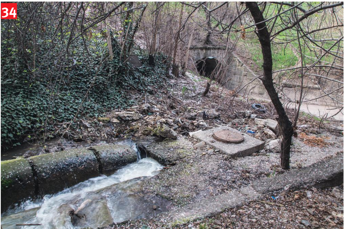
ფოტო 34, 35: ქალაქის განაშენიანებულ ნაწილში მდინარე ჩუღურეთისხევის წყალგამტარი გვირაბი მწყობრიდან არის გამოსული და ფეკალური წყლებით იტბორება ფშავის ქუჩის სავალი ნაწილი, რაც ძლიერ დისკომფორტს უქმნის ამ ქუჩის მცხოვრებთ.
