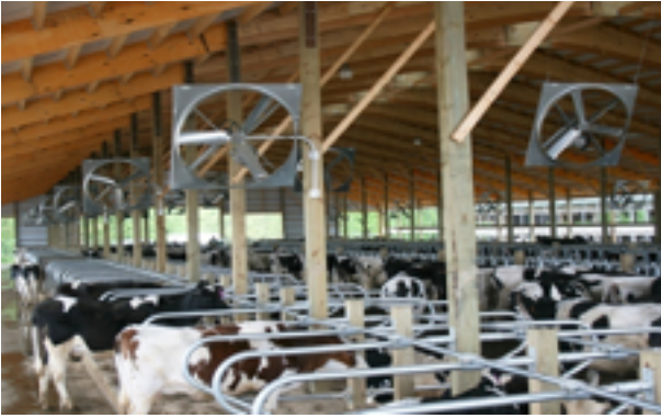
ნახ. 3.3.2. რეცირკულაციური ვენტილატორები
